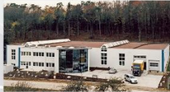
Neubau in der Reutlinger Straße
