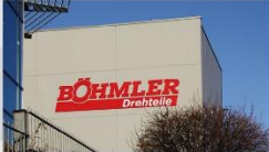
Draußensicht des fertigen Anbaus
