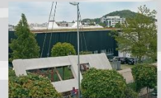
Montage der Ferrighianerteile
