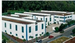
Erweiterung der Produktionshalle in der Reutlinger Straße
